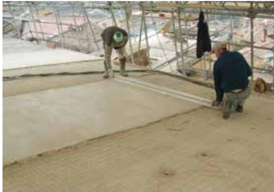
MasterEmaco® S 285 TIX'in perdahlanması
