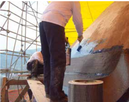
MasterBrace® FIB kullanılarak kubbe güçlendirilmesi
