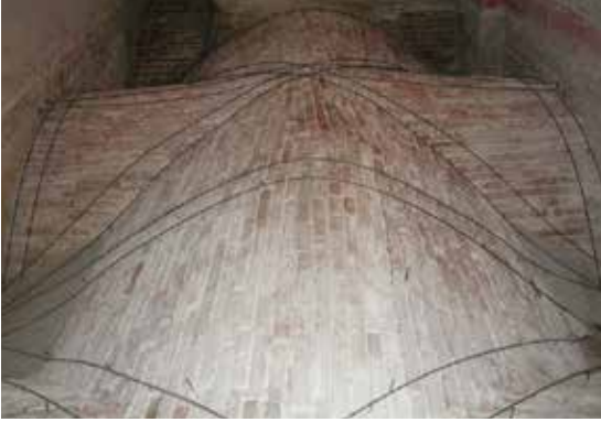
MasterEmaco® S 285 TIX uygulamasından önce karbon lifli polimer çubukların (MasterBrace® BAR) yerleştirilmesi
