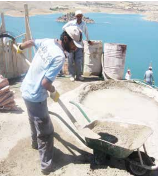
MasterEmaco® A 265 kullanılarak yapılan özgün harç hazırlığı
