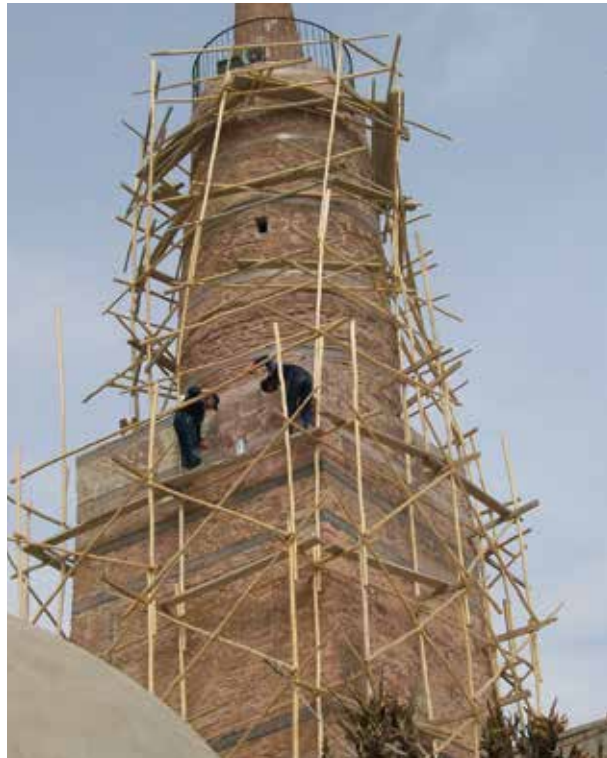
Tuğla minarenin lifli polimer kumaşlar ile güçlendirilmesi
