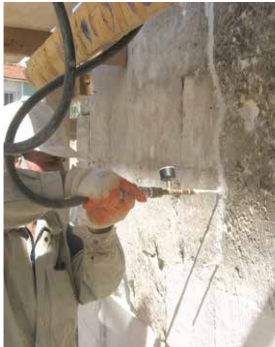
MasterInject® 222 ile çatlak onarımı
