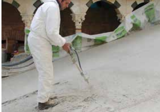
MasterEmaco® S 285 TIX kullanılarak tuğla çatının mantolanması
