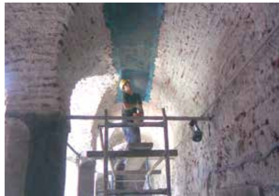
MasterBrace® FIB kullanılarak tuğla tonoz güçlendirilmesi
