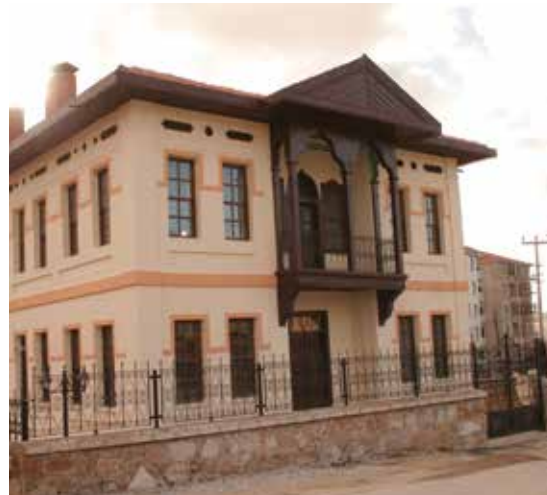
MasterEmaco® A 265 kullanılarak restore edilmiş bir bina cephesi
