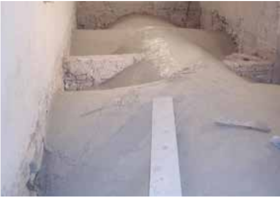
MasterEmaco® S 285 TIX ile mantolamanın bitirilmesi
