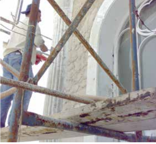
MasterEmaco® N 275 TIX'in mala ile uygulanması
