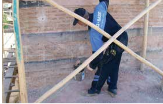
MasterBrace® FIB kullanılarak tuğla minare güçlendirilmesi
