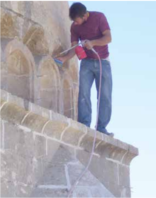
MasterInject® 222 kullanılarak taş kubbenin enjeksiyon uygulaması ile onarılması
