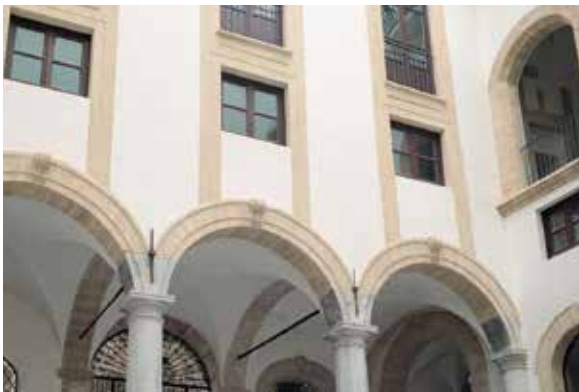
MasterEmaco® sıvalar kullanılarak tamamen yenilenmiş bir bina cephesinin genel görünüşü
