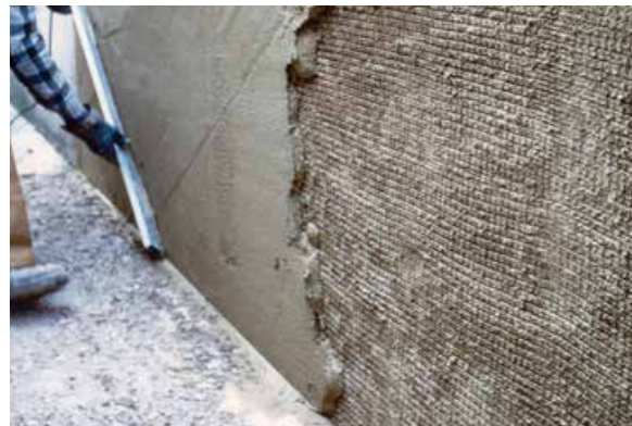
Makro gözenekli sıva ile nem yükselmesi problemi olan duvarın onarımı
