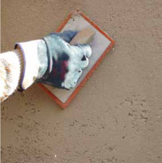
MasterEmaco® N 275 TIX'in perdahlanması
