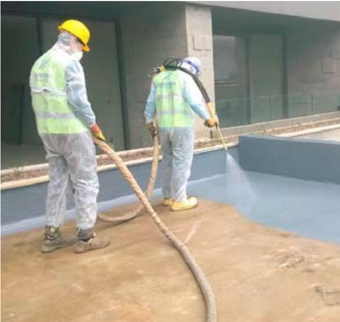
Sıcak Püskürtme Su İzolasyon ve Otopark Kaplama Sistemleri
