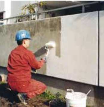
Prensip 2, yöntem 2.2 MasterProtect ve MasterSeal çimento, akrilik veya reçine esaslı, rijit veya esnek olabilen, betondaki nemi kontrol altında tutabilen koruyucu kaplamalardır.
