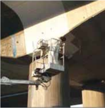
Prensip 1, yöntem 1.2 MasterProtect ve MasterSeal çimento, akrilik veya reçine esaslı, tüm madde girişlerine karşı koruma sağlayan koruyucu kaplamalardır.
