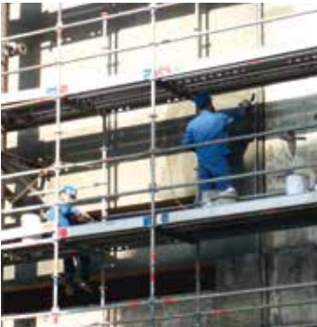
Prensip 3, yöntem 3.1 MasterEmaco elle uygulanabilen tamir harçlarıdır.
