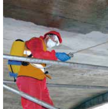
Prensip 9, yöntem 9.1 MasterProtect korozyon inhibitörleri donatıların korozyonunu engeller.
