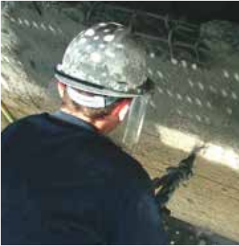
Prensip 7, yöntem 7.1 MasterEmaco paspayı güçlendirmesini spreysel uygulaması ile birlikte artırır.
