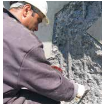
Prensip 11, yöntem 11.1 MasterEmaco astarları donatılarda aktif korozyon koruması sağlar.
