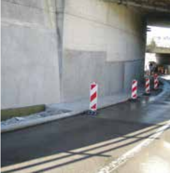
Prensip 7, yöntem 7.2 MasterEmaco klorür sebebiyle bozunmuş olan betonun onarımında kullanılır.
