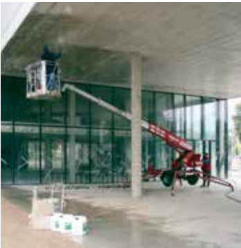
Prensip 8, yöntem 8.1 MasterProtect hidrofobik uygulamalarda kullanılır.
